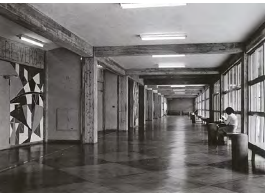
(創建時) 1964年 大きな開口部のコリドー※
