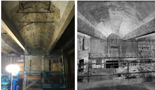
天井撤去後の3次元点群データによる測量
