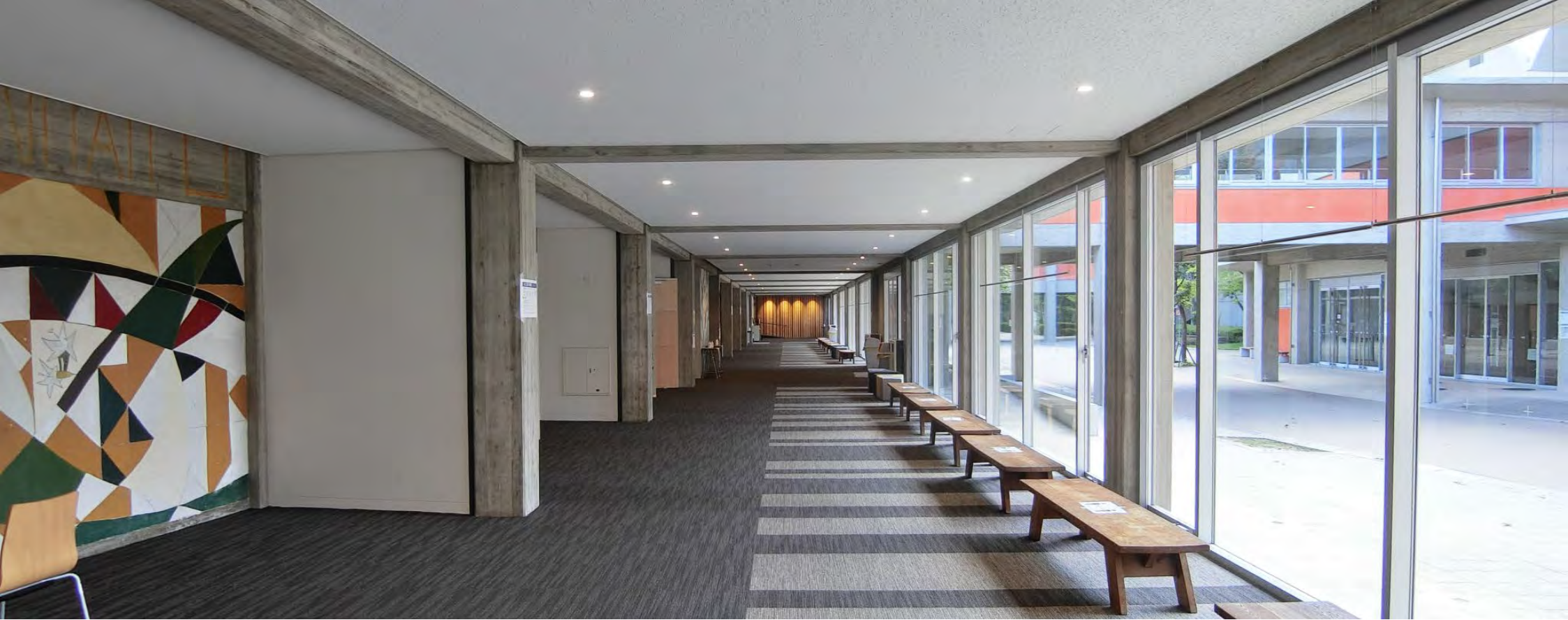
(改修後) アルミサッシを大型化し、メインストリートにより大きく開いたコリドー、学生の動線と居場所の一体化 1964製作の家具も再整備※※
