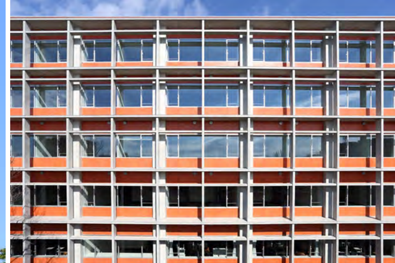
赤土色の壁・ルーバー・庇のデザインを継承した南西側のファサード※※
