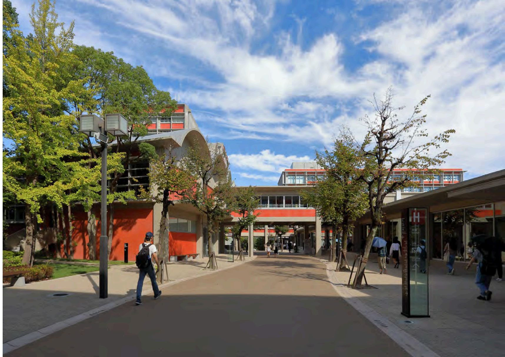
(改修後) 経年劣化の修復、バリアフリー化を進めたメインストリート※※
