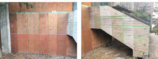
コンクリート打放し補修と赤土色の壁のモックアップ
