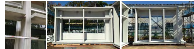
プレキャストコンクリートルーバーの実測とモックアップ確認
