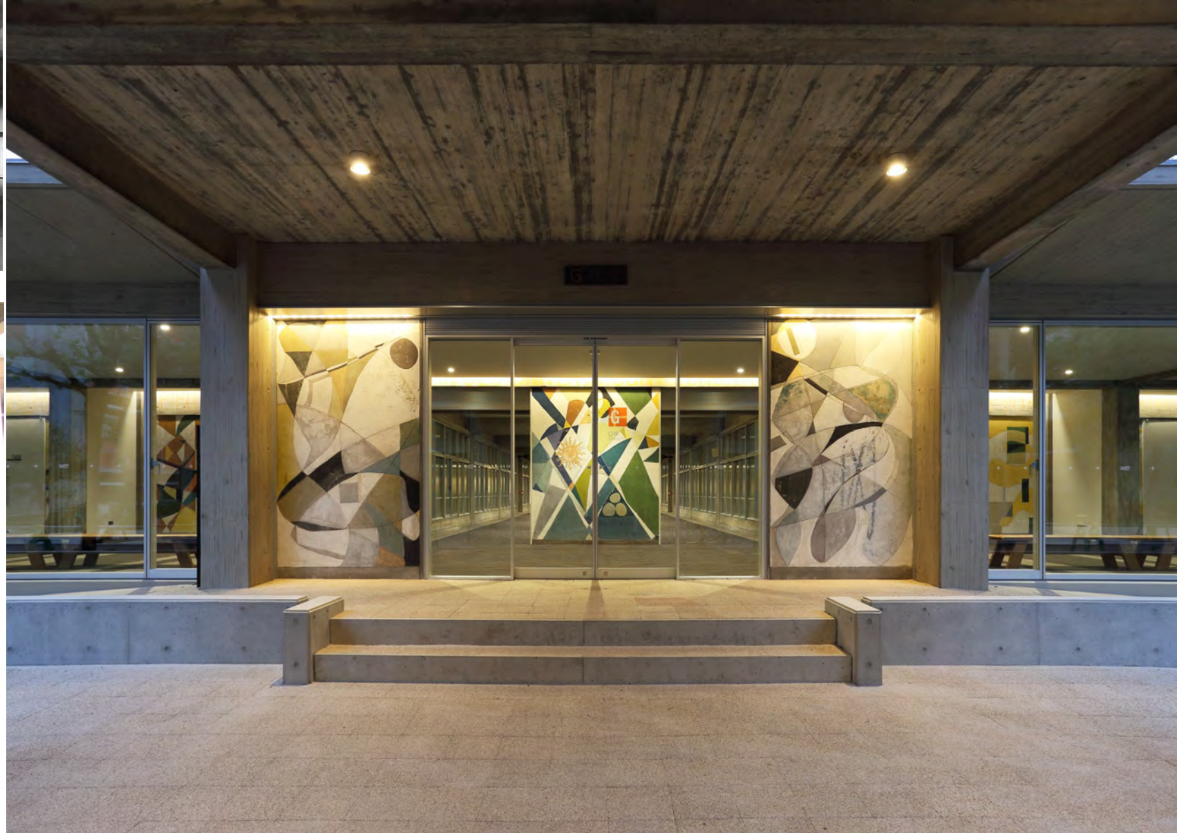
(改修後) 退色の進んだ壁画を再び浮き上がらせる間接照明と開口部の再整備 メインエントランスのバリアフリー化※※
