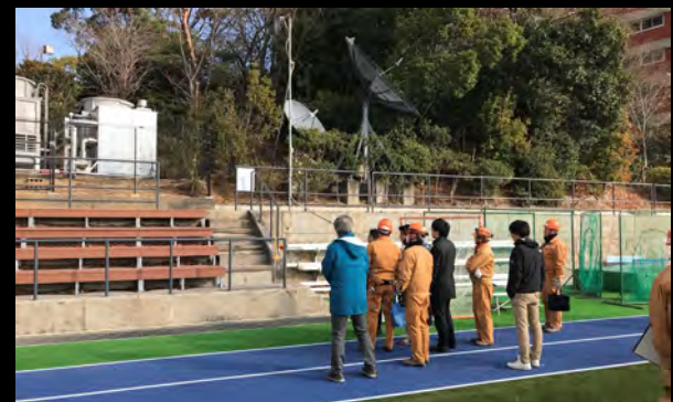
外構の高低差解消法の確認
