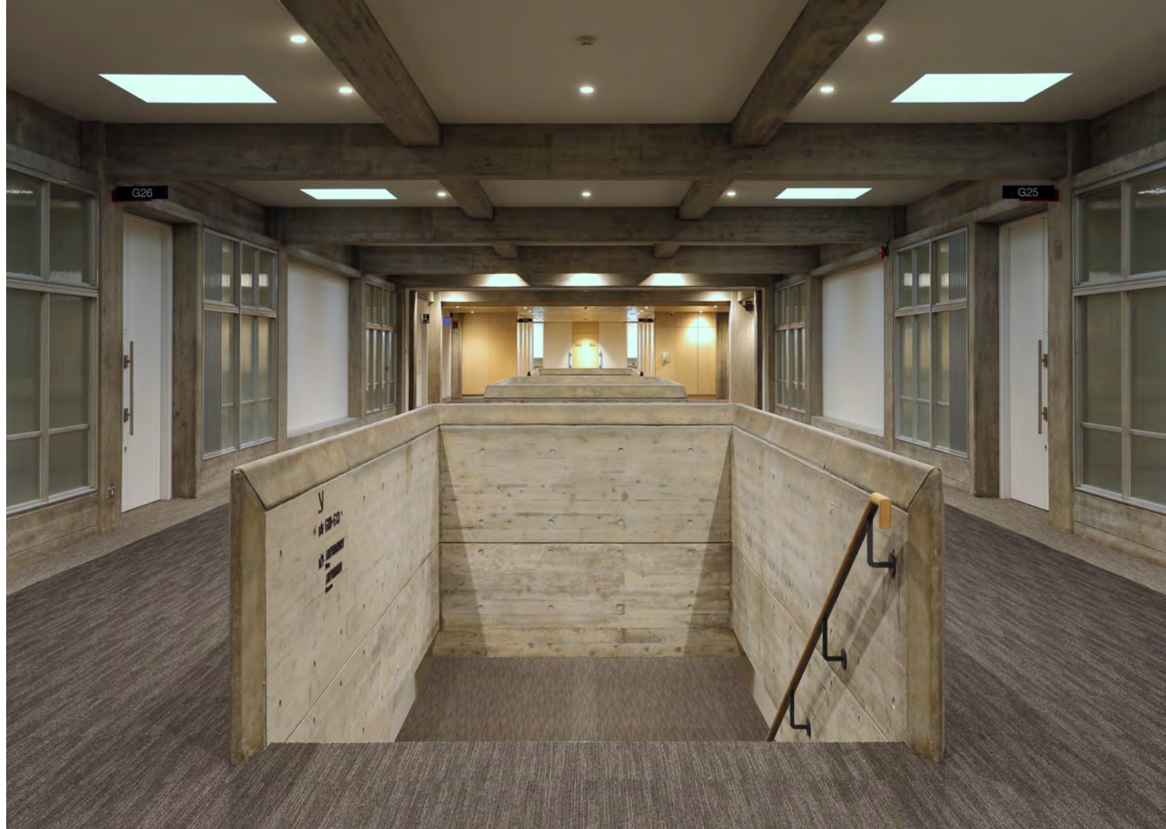
(改修後) 創建当時のトップライト、教室⇄中廊下の採光をとる屋内のアルミサッシと型ガラスの保存※※
