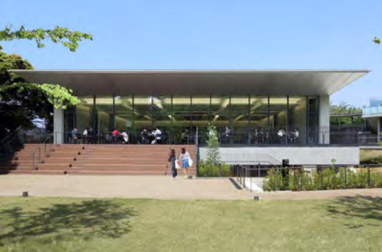
食堂・テラス・前庭へと連続する空間構成***
