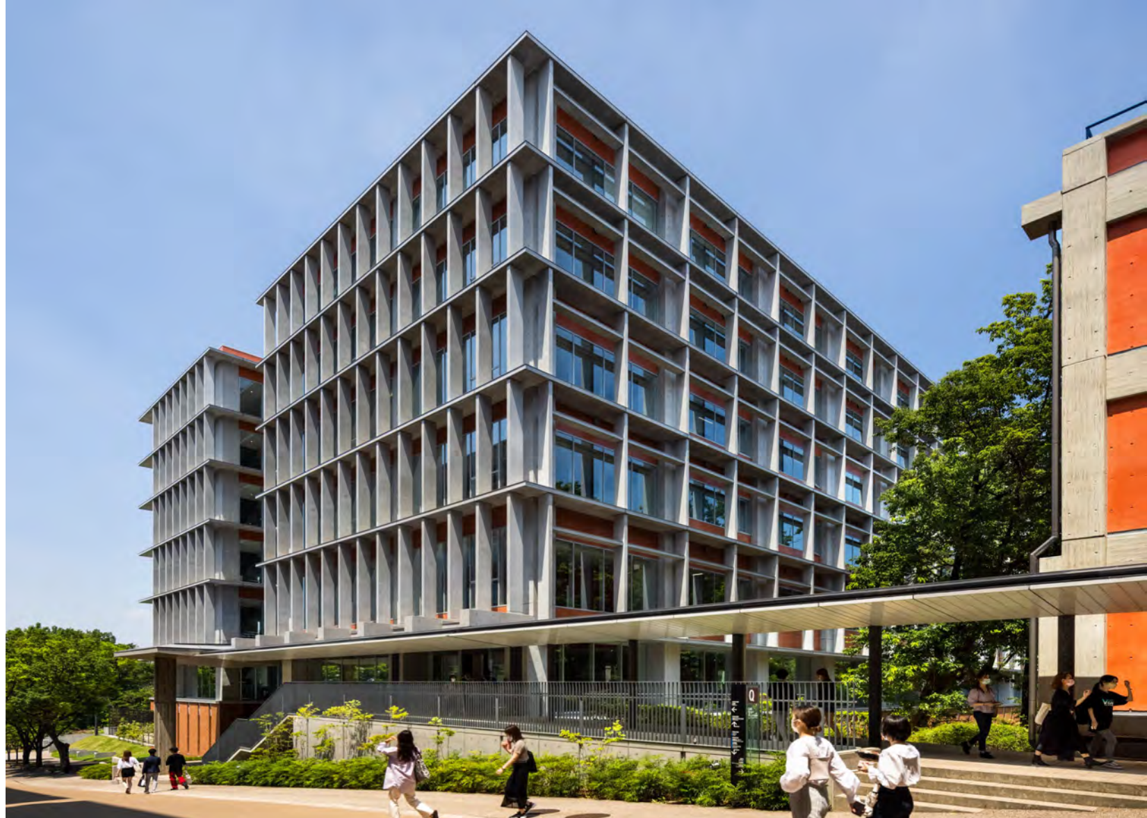
南西側のファサード 赤土色の壁とルーバー、庇を継承した外観※※※
