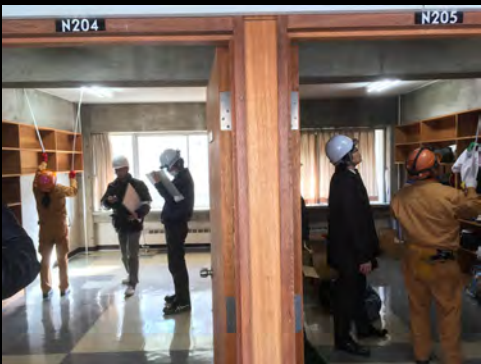
天井設備の改修検討のための測量調査
