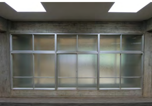
(改修後) 1964年のガラス製作法でつくられ 遺産として保存した型ガラス
