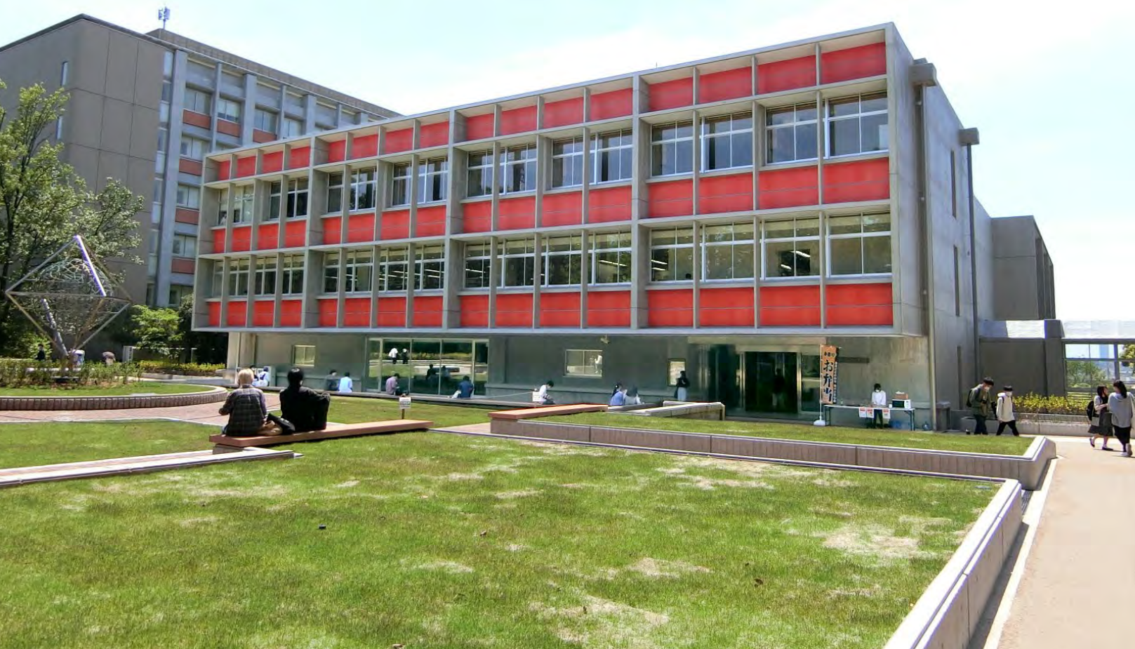
(改修後) 前庭と連続し、メインストリートに開いた図書館正面
