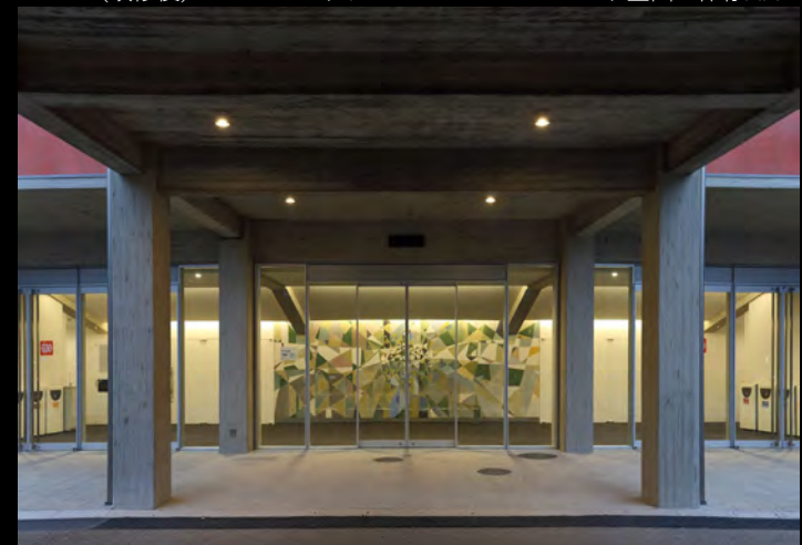
(改修後) メインストリートからも見えるレーモンドの壁画※※
