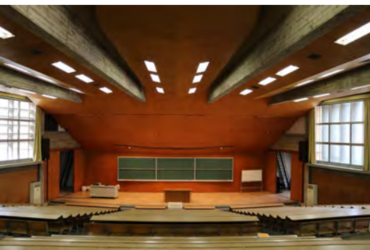
(改修前) 空調設備やA V設備の増設状況
