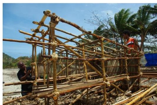
写真 18 : 籐によるラカトイの部材の結縛:
